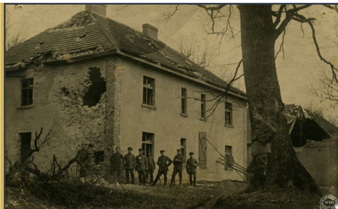
Front północny, grupa powstańców z Nakła przed budynkami uszkodzonymi w czasie walk, 1919 r. (Wojskowe Biuro Historyczne im. gen. K. Sosnkowskiego).
