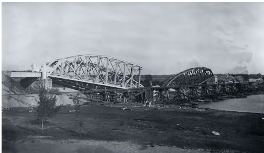
Fot. 4 Most na Niemnie zniszczony podczas inwazji bolszewickiej w 1920 r.
